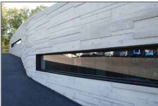
Eine besondere Herausforderung für die Bauausführenden war die Herstellung der Fassade, wegen der reliefartigen Struktur und auch wegen der großen Fenster, die bei der Herstellung der Flächen Berücksichtigung finden mussten.
