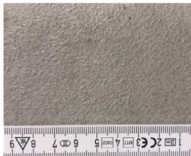
Betonoberfläche nach Herstellung mit Schalungsplatte mit Struktur
